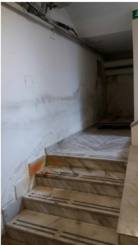
Foto n° 5 – Scale di accesso al piano interrato.
