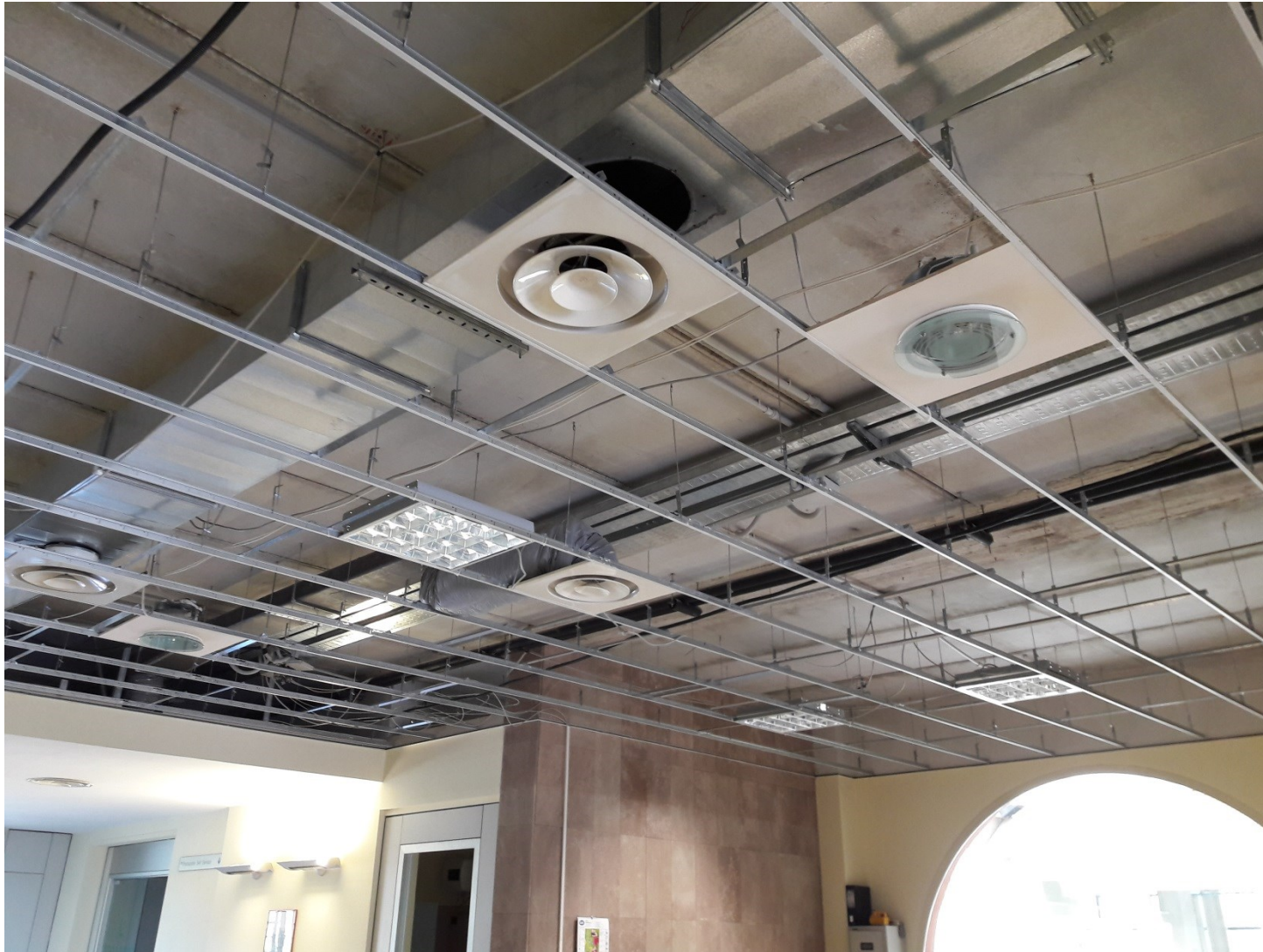
Foto del controsoffitto nella zona dell'atrio di ingresso al piano terra
