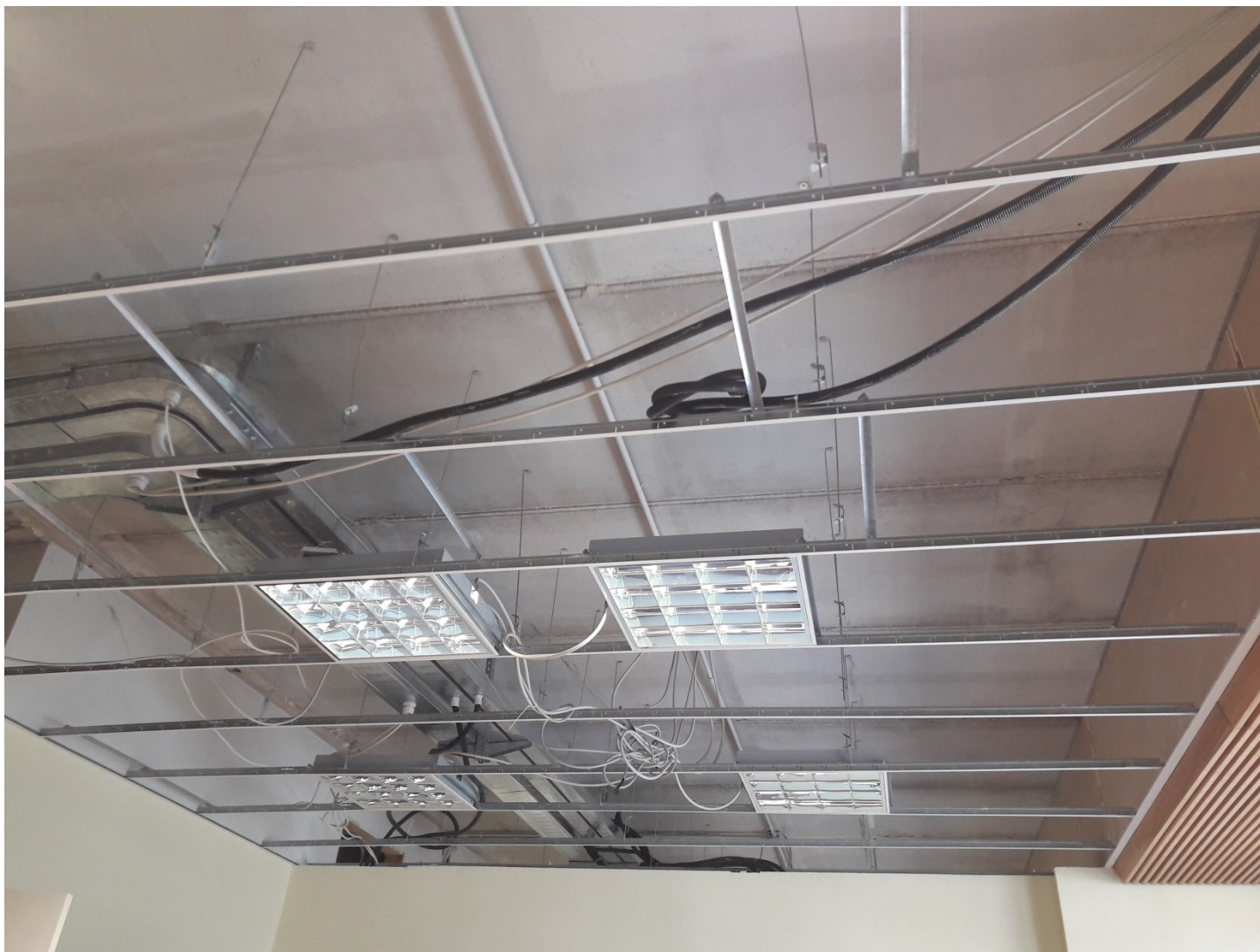
Foto del controsoffitto in un ufficio al primo piano
