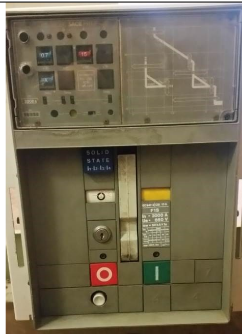
Interruttore a carrello a servizio del sistema di commutazione rete preferenziale/gruppo elettrogeno – dati tecnici
