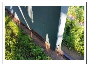
Parti danneggiate a seguito di corrosione per esposizione agli agenti atmosferici
