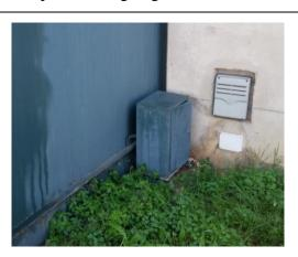
Alloggiamento del motoriduttore e cassetta di derivazione in prossimità
