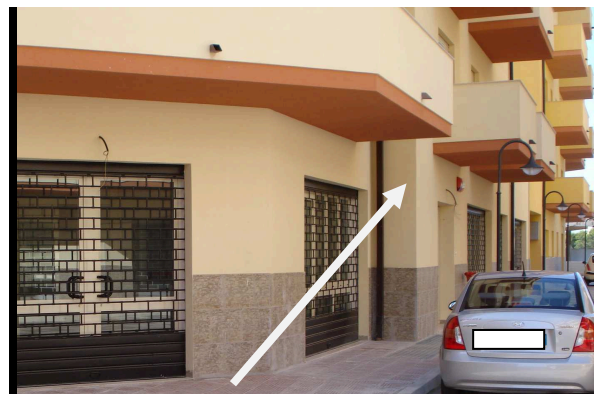
Parete del locale front-office in cui ricollocare la telecamera
