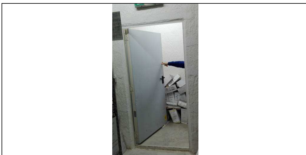
Porta REI del locale archivio in cui occorre sostituire la serratura
