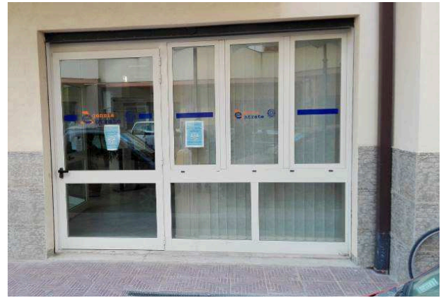
Infisso esterno U.S. Front-Office
