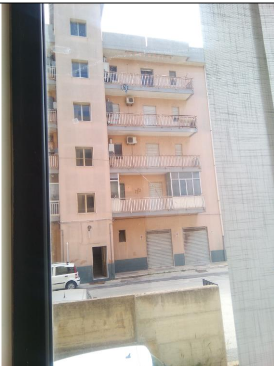
Lesioni sulla superficie vetrata
