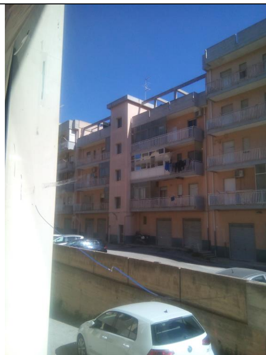
Lesioni sulla superficie vetrata
