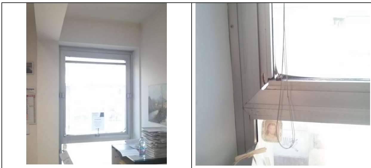
infisso esterno in alluminio anodizzato "Silver" ubicato al piano secondo - stanza 1
