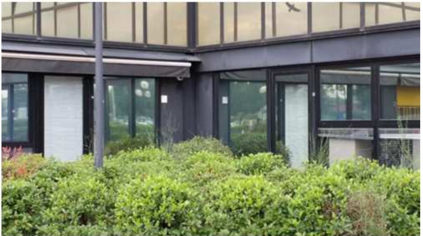
4 Particolare angolo con edificio limitrofo ITT
